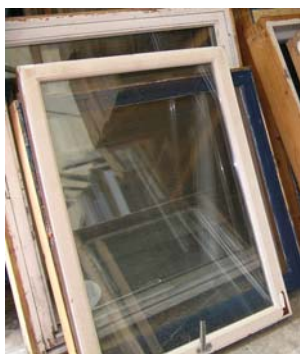
Isoleringsruter: Norske ruter fra 1965 – 75 og importerte ruter fram til 1980, inneholder som oftest PCB. Rutene må merkes og leveres som farlig avfall når de kasseres.
